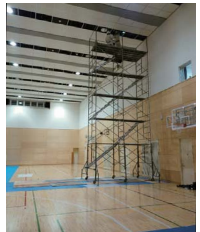
1 天井パノラマ動画撮影時の足場
