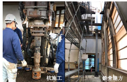
図7 建屋内での施工
